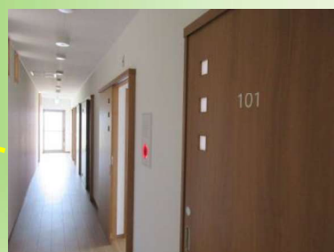
個室は吊り戸にして、入り口の段差をなくしました。
